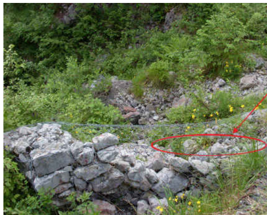
Esempi di gabbionate metalliche danneggiate dalla caduta massi nella zona superiore della Valle Spirola
