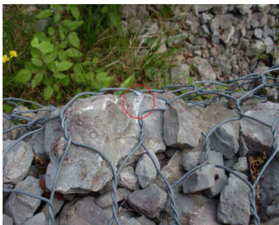
Esempi di gabbionate metalliche danneggiate dalla caduta massi nella zona superiore della Valle Spirola
