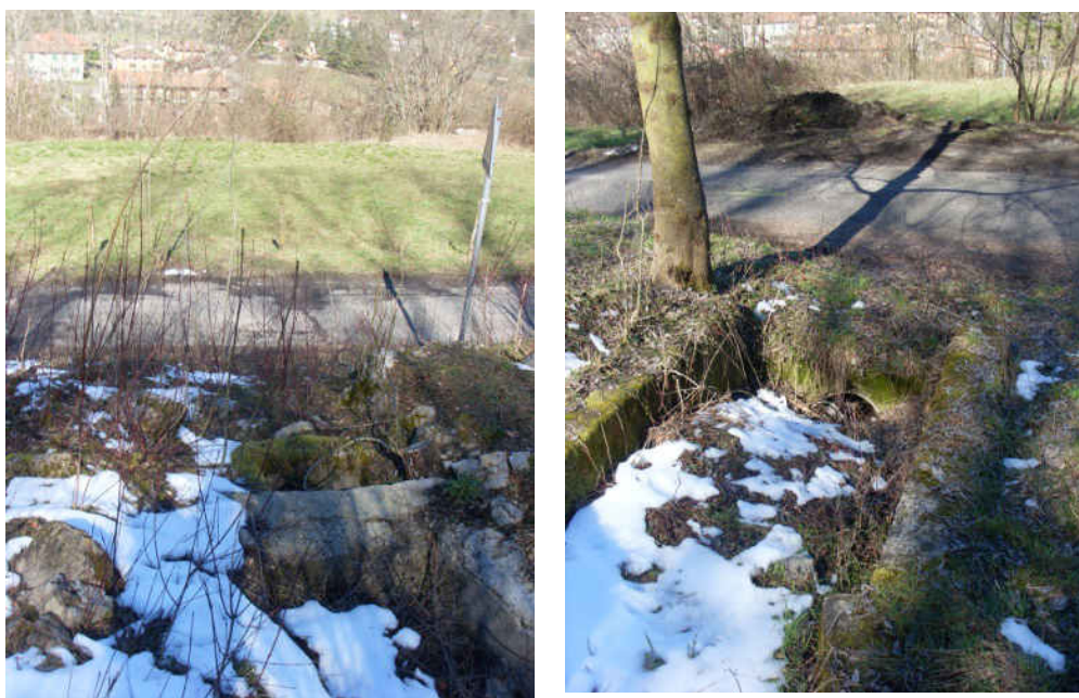
Tubature intasate lungo la Stradella della Vidalba
