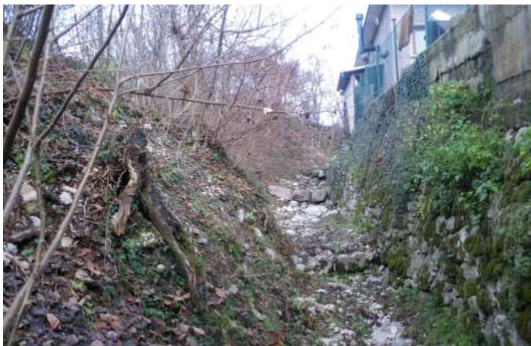
Figura 38- Serie di briglie in massi ciclopici lungo l'alveo
