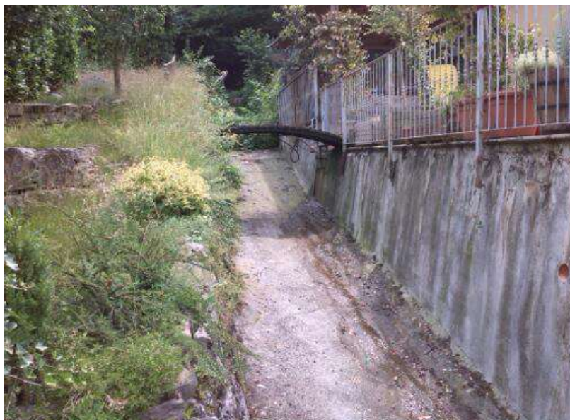
Figura 36- Tratto d'alveo con lastricatura in cemento
